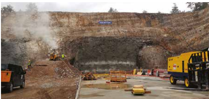
Predvokop predora T1 v bližini Lokve.
